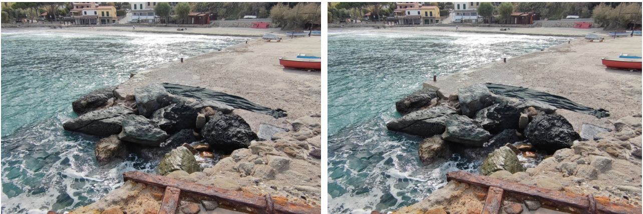
Figura 9 Tratto terminale di banchina crollato: vista da mare (sinistra) e rendering del ripristino (destra)
