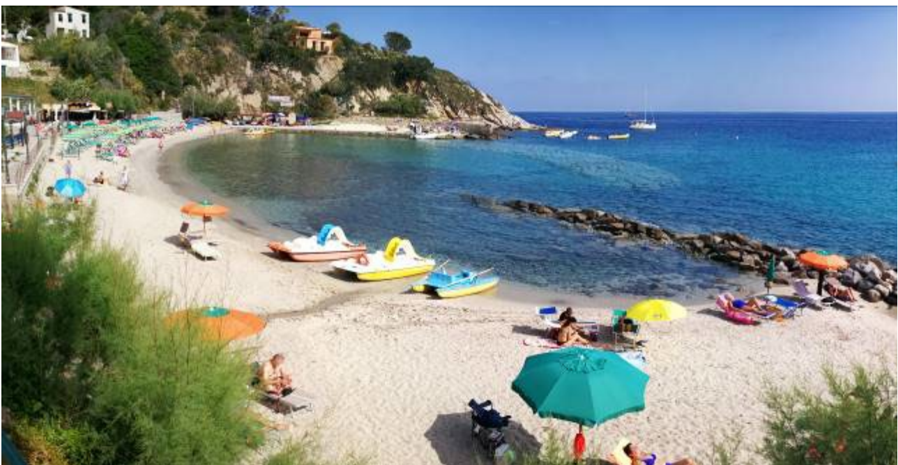
Figura 13 Ripristino della testata della scogliera radente ad Est con massi semiaffioranti
